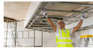
Travail en hauteur sur échafaudages de pied (R408)
