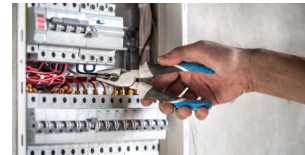
Habilitation Electrique BS
